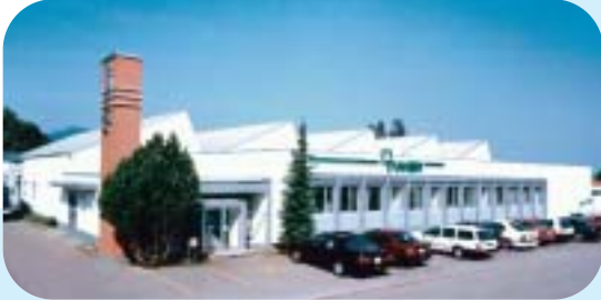
Produktionsstätte Meisterschwanden Production site in Meisterschwanden
